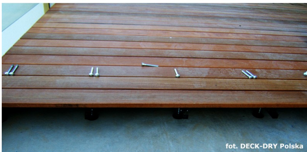
fot. DECK-DRY Polska
