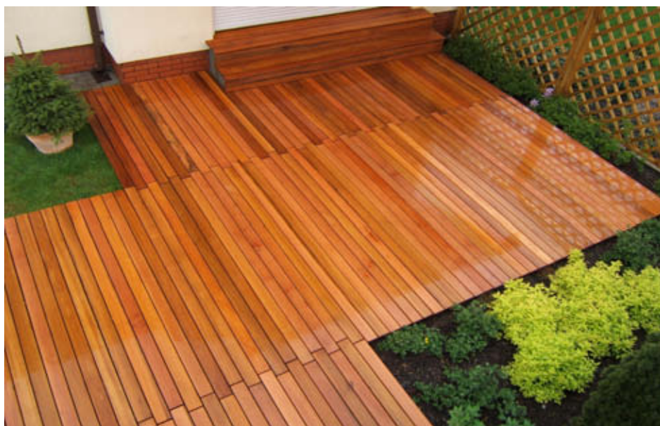
deska bangkirai , gładka 8,8 x 1,8 cm / polietylenowe. podkładki 1,3 cm + polietylen. legary montażowe deck-u 3,0 cm / deck poziomy / podłoże – kostka brukowa
